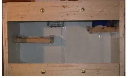
Beim Verkleiden muß man nur darauf achten. daß oben und unten an exakt gleichen den Stellen wie bei den Spanplatten 45mm-Löcher gebohrt werden. Diese werden mit den Lüftungsgittern abgedeckt. Und fertig ist das Terrarium.
