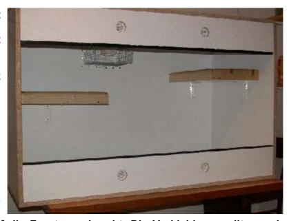
Leimholzplatten auf die Front geschraubt. Die Verkleidung sollte an der Oberkante 2cm höher sein als das Terrarium, wenn man mehrere Terrarien übereinanderstellen will. So können Leisten als Abstandshalter auf dem Terrarium befestigt werden, damit das Kabel der Heizung oben durchgeführt werden kann. Außerdem verhindert man dadurch ein zu starkes Aufheizen der Bodenplatte des darüber befindlichen Terrariums.
