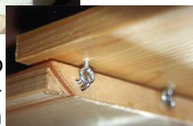
Die Öffnung des Hacken muss am Ende nach unten (also von der Lauffläche weg) zeigen, es darf gerade soviel Platz zwischen Hacken und Holz sein, dass die Öse durch Unterseite der Ebene geschraubt werden kann. Aufpassen, dass die Abstände zwischen den Ösen die gleichen sind wie zwischen den Hacken sind, da die drei Hacken später in weit rein drehen, dass sie genug Luft bleibt, um die Rampe hochzuklappen. Auf dem unteren Bild sieht man, wie es nach Möglichkeit aussehen sollte.
