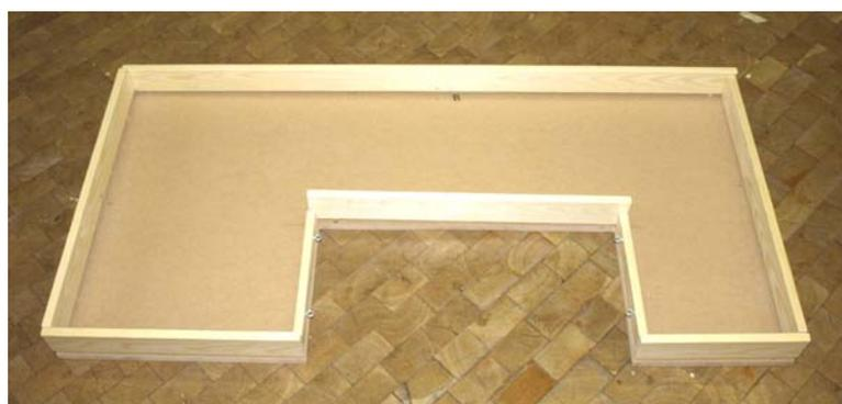
An Position 7 verwenden Sie die 30 x 14 mm und 22,6 cm lange Leiste und verschrauben diese auch mit der Grundplatte. Schrauben Sie in die Leiste (Pos. 7) die Ringschrauben im Abstand von ca. 13 cm. Zur leichteren Montage bohren Sie mit dem 2 mm-Bohrer die Löcher vor. Lassen Sie von der rechten und linken Seite je ca. 5 cm Abstand, dann ergeben sich die knapp 13 cm.
